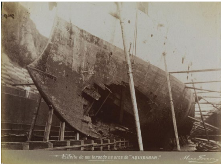
Figura 1 – Efeito de um torpedo na proa do Aquidabã Fonte: Marc Ferrez / Acervo Fundação Biblioteca Nacional
