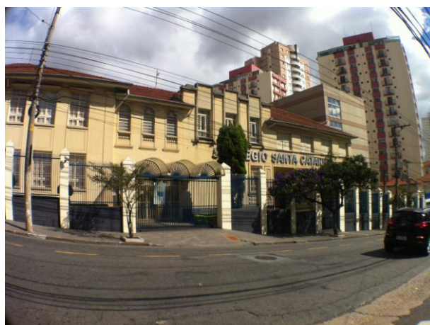
Figura 19: Colégio Santa Catarina, na Rua da Mooca, em 2014. (Fonte: Elaborada pela autora).
