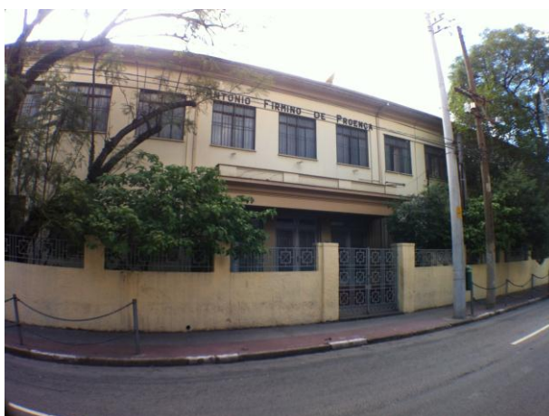
Figura 10: Fachada da EE Firmino de Proença, em 2014. Fonte: Elaborada pela autora.
