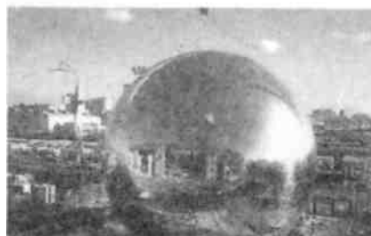
Etapas da construção da Geode , La Villete, Paris, França. De abril de 1983 a dezembro de 1984
