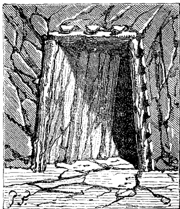
Fig. 114. — Galeria de mina, forrada de madeira.
