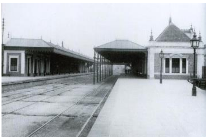
Segunda estação do Brás. Fonte: http://www.estacoesferroviarias.com.br/b/braz.htm
